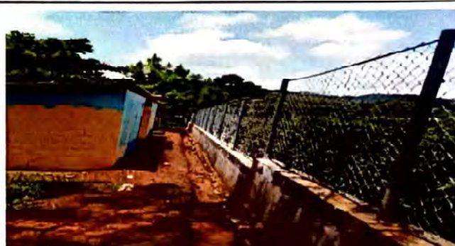
Foto 4: Muestra la instalacion de la malla parte lateral izquierdo.
