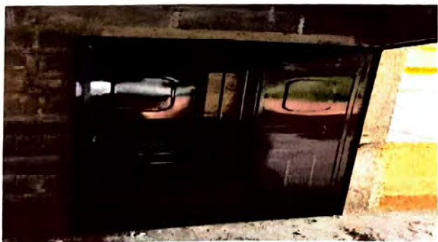
Foto 5: Muestra la instalación de puerta de metal.
