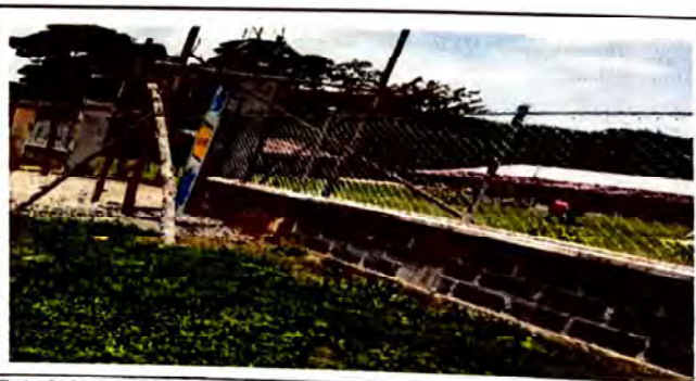
Foto 6: Muestra la colocacion de la malla frontal.
