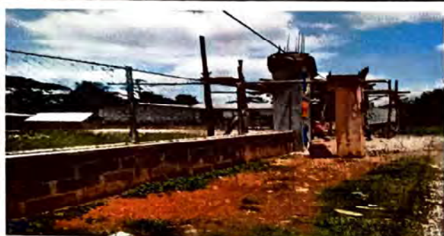
Foto1: Muestra la instalacion de la malla parte frontal.
