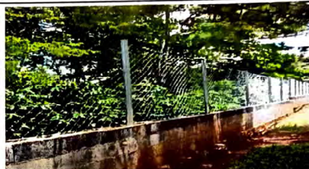
Foto 2: Muestra la instalacion de la malla parte lateral derecho.
