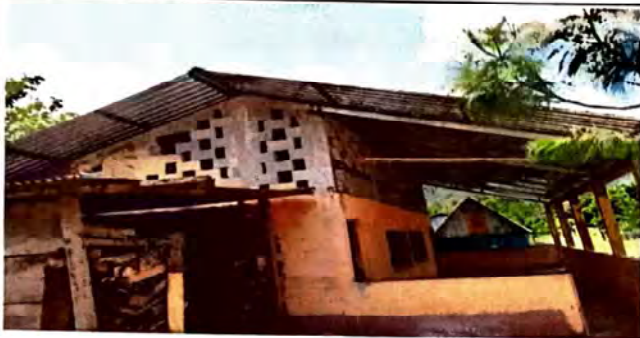
Foto 1: Muestra el nuevo techo troquelado.
