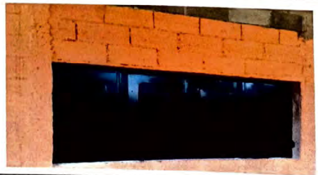
Foto 6: Muestra la ventana de metal instalada.
