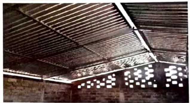
Foto 2: Muestra la estructura con techo concluido.
