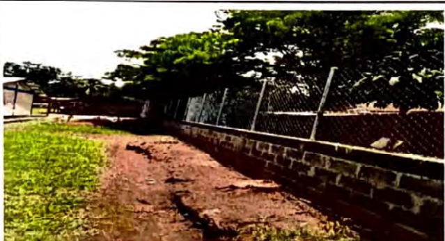
Foto 3: Muestra la instalacion de la malla lateral derecho.
